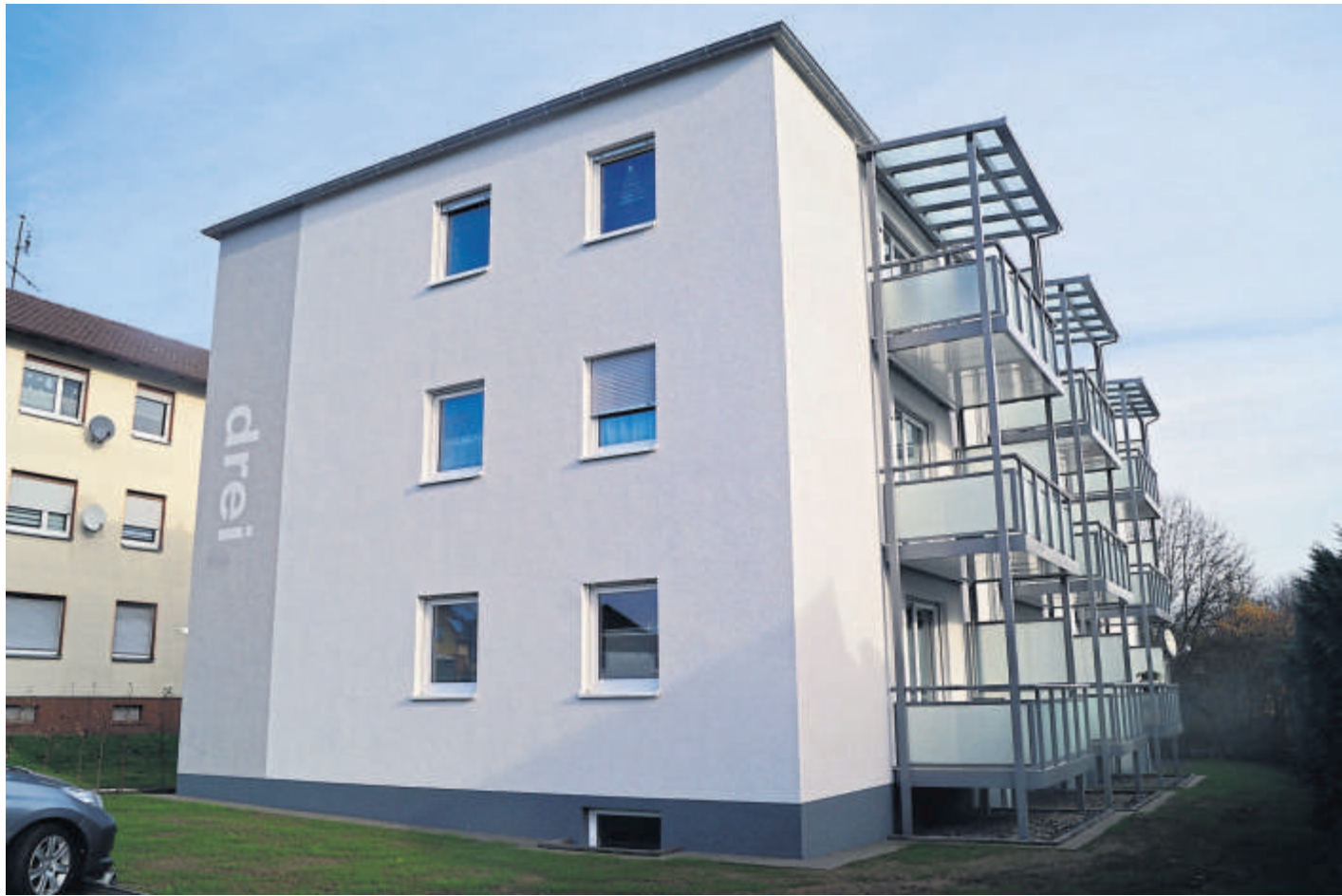
In der Lindenau in Lindenstruth hat die Baugenossenschaft im ersten von drei bestehenden Gebäuden neue Wohnungen geschaffen. Die weiteren Gebäude folgen in den kommenden Jahren.
